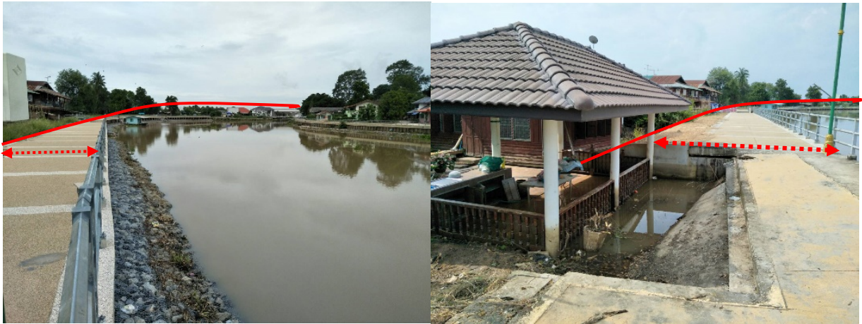
ภาพที่ ๖ เชื่อนป้องกันตลิ่งริมแม่น้ำบางปะกง รุกเข้าไปในลำน้ำและปิดกั้นทางระบายน้ำ ทำให้เกิดภาวะน้ำท่วมขังในชุมชนเพราะน้ำฝนระบายลงแม่น้ำไม่ได้
