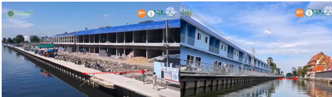
ภาพที่ ๔ การพัฒนาโดยการจัดระเบียบที่อยู่อาศัยริมคลองเปรมประชากร ช่วงก่อสร้าง และเมื่อแล้วเสร็จ รื้อถ้ำลำน้ำส่งผลให้ทางน้ำแคบลง
