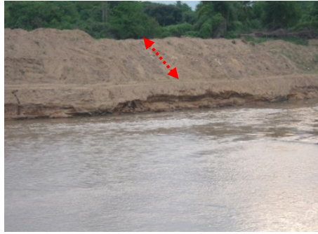
ภาพที่ ๙ ขุดดินแล้วนำไปกองข้างตลิ่งแม่น้ำ เมื่อฝนตกดินจะไหลกลับลงสู่แม่น้ำ
