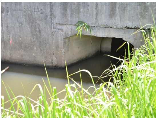
ภาพที่ ๑๘ การก่อสร้างถนน ขนาคองเปิดที่บังคับให้น้ำไหลผ่านได้ไม่ถึง ๑ ใน ๑๐ ของทางน้ำเดิม
