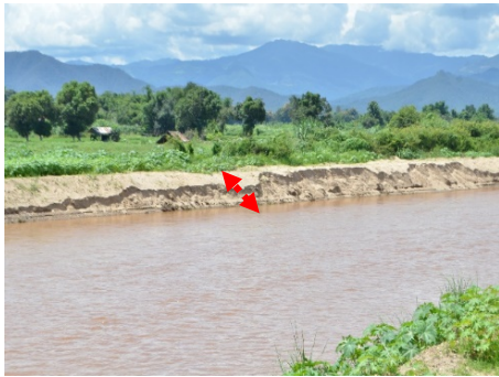
ภาพที่ ๑๐ คันทรายถูกกัดเซาะอย่างรวดเร็ว ทำให้ท้องน้ำกลับมาตื้นเขินเหมือนเดิม
